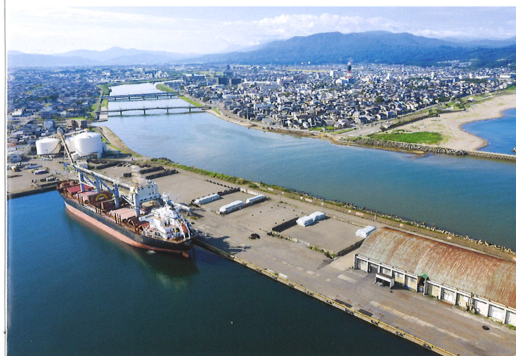
西埠頭 1・2号岸壁があり、係留能力は共にD/W15,000tです。1号岸壁にはアンローダーが設置されており、水酸化アルミニウムの荷役に使用されています。 West pier There are 2 berths which have mooring abilities of D/W 15,000t. An unloader is equipped on No.1 berth and used for handling cargo of Almina.
