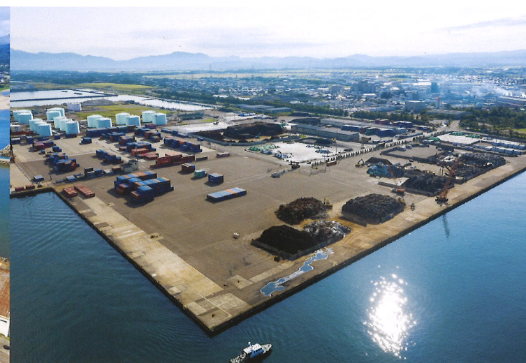
東埠頭 1～4号岸壁があり、1・2号岸壁は主にスクラップ船の荷役に使用、3号岸壁は多目的に使用されており、4号岸壁はD/W12,000tの係留能力があり、新潟県所有のガントリークレーンが設置され海上コンテナ船の荷役に使用されています。 East pier There are 4 berths. No.1 & 2 berths are used for handling cargo of scrap mainly. No.3 berth is used for many purposes. No.4 berth has a mooring ability of D/W 12,000t. A gantry crane which is owned by Niigata pref. is equipped there and it is used for handling cargo of containers.
